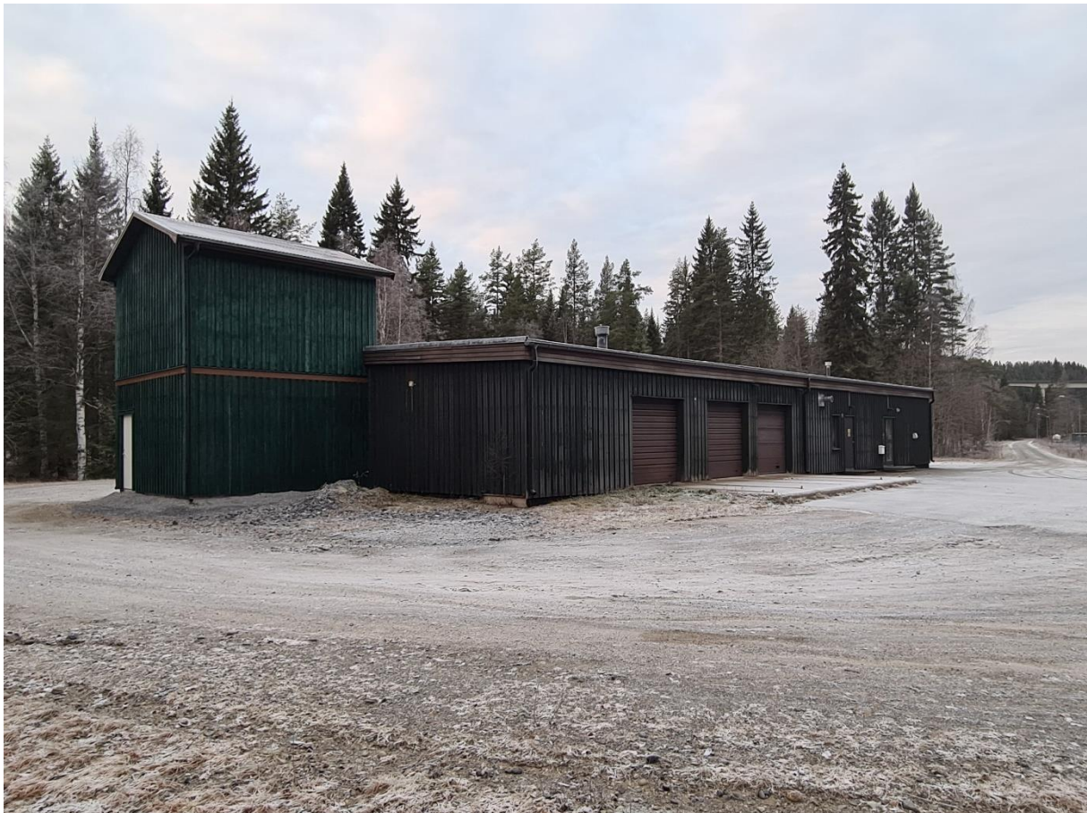
Figur 3. Reningsverket i Bjurholm.
