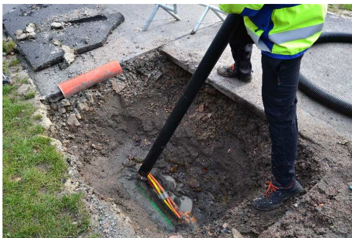
Exempel på grävsugning vid befintliga ledningar
